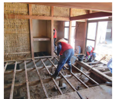
個人宅での土砂の撤去(倉敷市)
